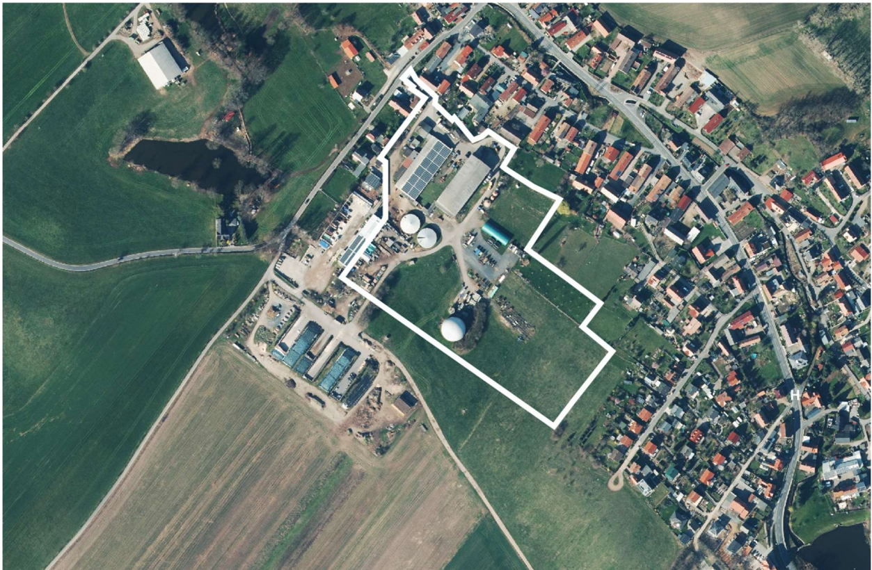
Abb.: Luftbild Plangebiet (Quelle: Geoportal Sachsenatlas)
